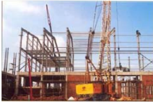
Xây lắp kết cấu nhà máy kính nổi Bình Dương
