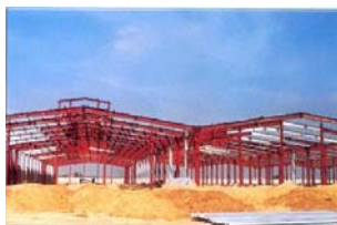
Chế tạo và lắp đặt kết cấu nhà máy gạch Đồng Nai Dương
