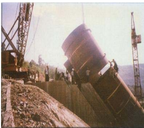
Chế tạo và lắp đặt đường ống áp lực Nhà máy thủy điện Thác Mơ ở độ nghiêng 52,
