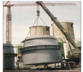
Lắp đặt Silo thu bụi nhà máy xi măng Sao Mai - Kiên Giang, Nhà máy xi măng Sao Mai - Kiên Giang thủy điện Hàm Thuận - Đa Mi
