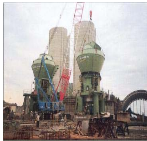
Lắp đặt thiết bị nghìn xi măng - Nhà máy xi măng Sao Mai
