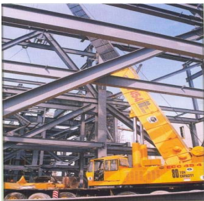
Chế tạo, lắp dựng kết cấu khung lò hoi - Nhà máy nhiệt điện Phú Mỹ Đồng Nai Dương
