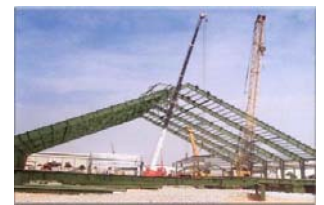
Chế tạo và lắp dựng nhà vòm khẩu độ 58m. Nhà máy xi măng Sao Mai - Kiên Gianthủ điện
