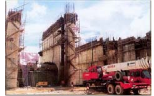
Thi công xây dựng đập tràn xả lũ - Dự án thủy điện Hàm Thuận - Đa Mi
