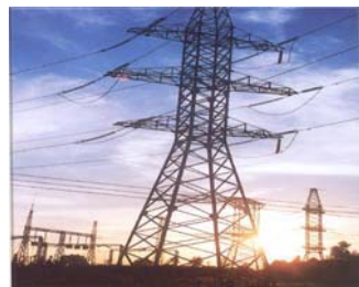
Chế tạo và lắp đặt đường dây cao thế
